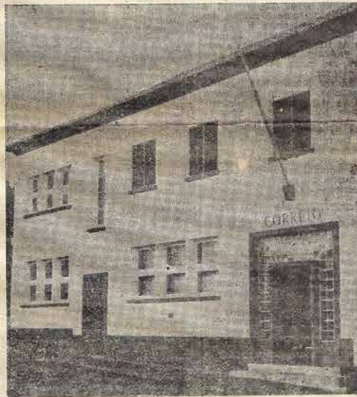
Edifício de Santana
